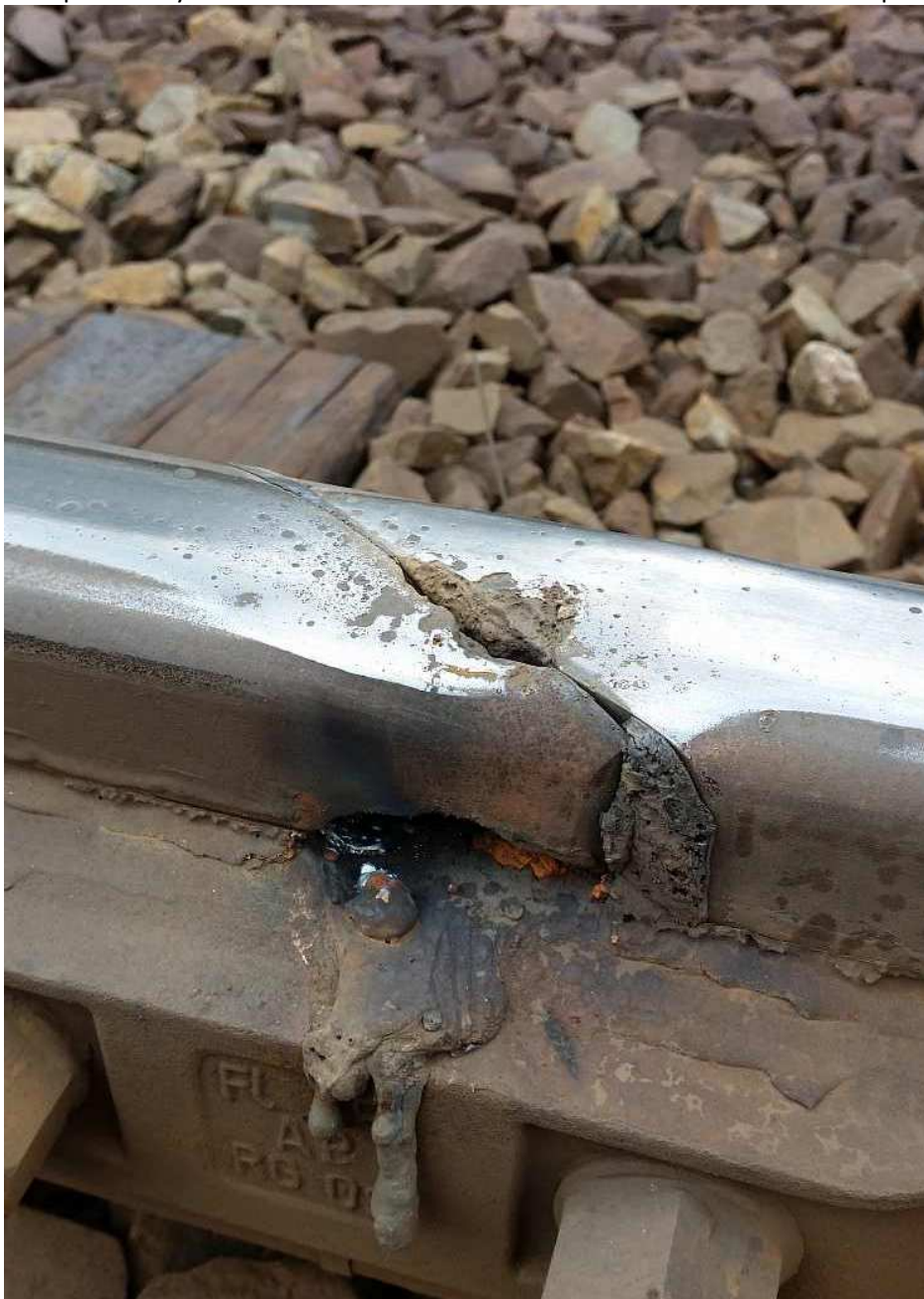
Obr: poškozený IS vlivem elektrického oblouku na trati v okolí neutrálního pole
